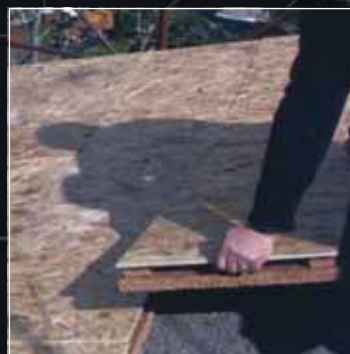
1. Posa pannello Ventiltec®
