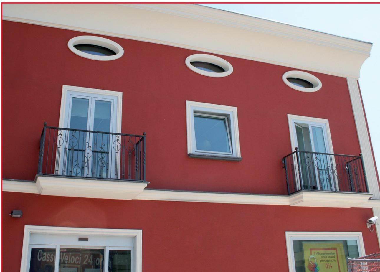
PROFIL.DECOR sono realizzati in polistirolo espanso con rivestimento sulla parte sagomata a vista, garantendo una elevata resistenza e flessione, ed una durabilità nel tempo pari ad un comune manufatto in cemento.
