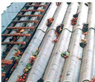
Accumuli di foglie: pericoli di formazione di dighe ed intasamento dei canali. Utile installazione di una passerella di servizio.
