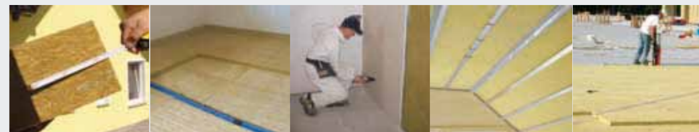
isolamento di facciata
