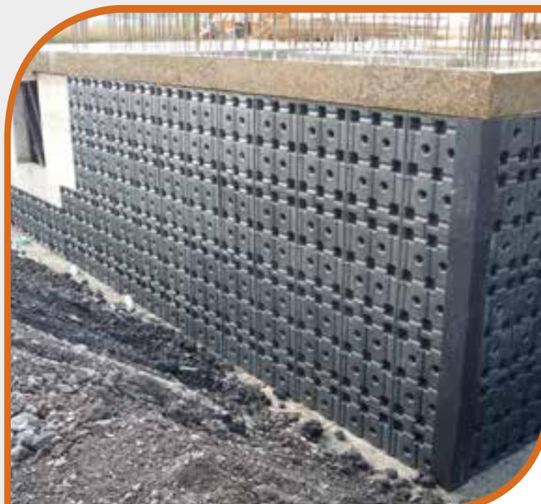
Le basi di appoggio, pari a 755 cmq/mq. di superficie, presentano una forma tale da non provocare nessun danneggiamento allo strato impermeabile.
